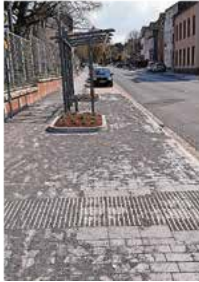
gässchen aufgenommen. Hier wird die Straßenoberfläche in Pflaster hergestellt.
