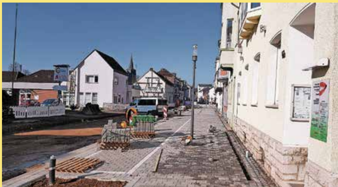
Die Arbeiten auf der Rurstraße wurden im Januar wiederaufgenommen. Bis heute wurden Straßenablaufleitungen gelegt, ein Hausanschluss saniert, beidseitig Leerrohre für die Stadt verlegt, sowie die Borde und Rinne auf der Seite mit den ungeraden Hausnummern vom Bendenweg bis Place de Lesquin gesetzt. Das Natursteinpflasterband wurde ebenfalls weitestgehend gesetzt. Aktuell wird das Pflaster verlegt. Zeitnah soll ebenfalls mit den Arbeiten auf der Seite mit den geraden Hausnummern begonnen werden.
